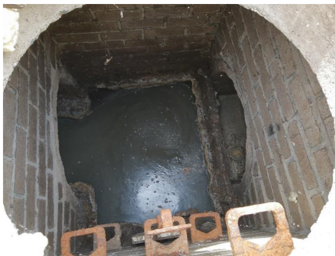
Obr. 1 Odlehčovací komora OK10 (fotodokumentace z terénního průzkumu)
